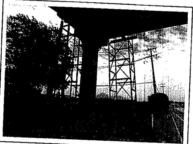
Foto 32. Km. 21.800 Pasarela Lo Pinto, solo alzaprimado provisorio, sin reparaciones.
